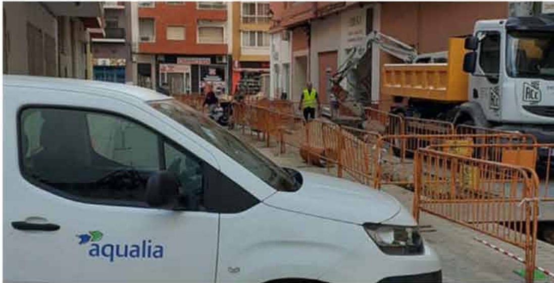
Obras de renovación de la red en una calle de Dénia en una imagen de archivo.
