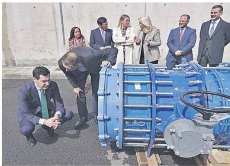
Moreno visita una obra clave para la conexión de Málaga con el Guadiaro.
