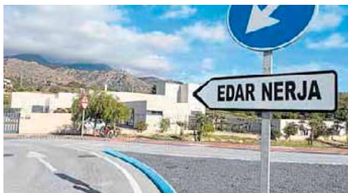
Planta de tratamiento de las aguas residuales de Nerja. E. C.
