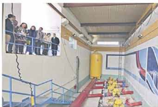
Primera piedra para el bombeo de Rojas.
