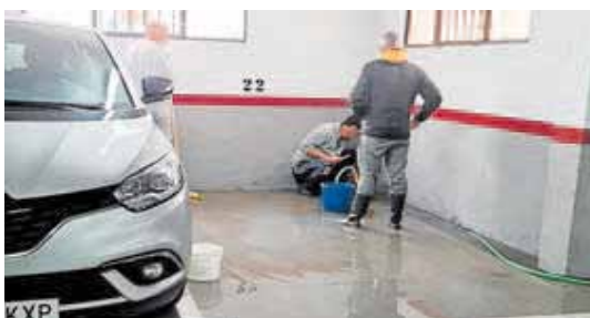
Un vecino revisa las grietas de dilatación por la que sale agua. HOY
